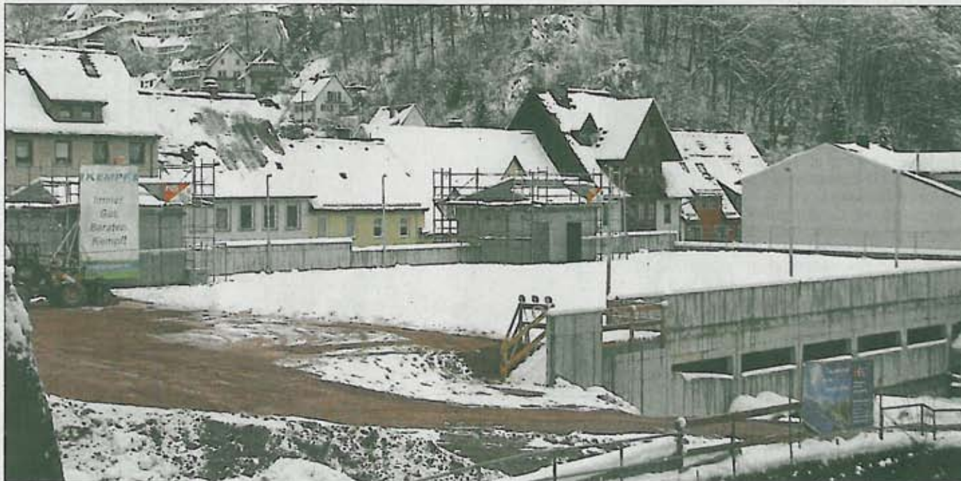
Rechtzeitig zum Beginn des Weihnachtszaubers am 25. Dezember ist das Oberdeck des neuen Parkhauses in der Triburger Innenstadt fertig gestellt. Die Fläche bietet Platz für rund 90 Autos. Foto: Liebau
